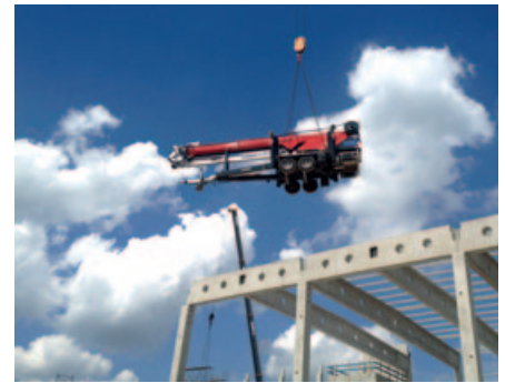
Durch das geringe Eigengewicht kann der Kran auch problemlos auf unzugängliche Plätze eingehoben werden
